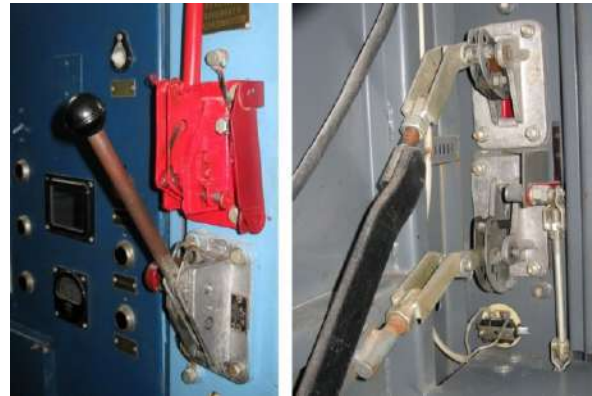
Ручний привод лінійного роз'єднувача
