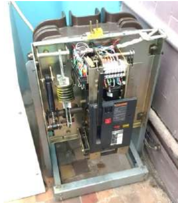
Елегазовий вимикач
