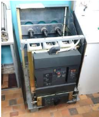
Вакуумний вимикач
