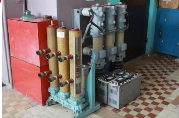
Малооб'ємний вимикач, ізолятор
