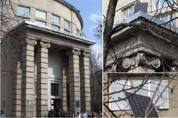
Фотоелектрична панель на електрокорпусі ХІІІ
